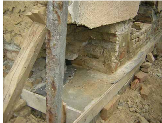
Neue Horizontalsperre unter vorhandenem Giebel einmauern
