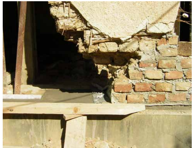
Neue Horizontalsperre unter vorhandenem Giebel einmauern
