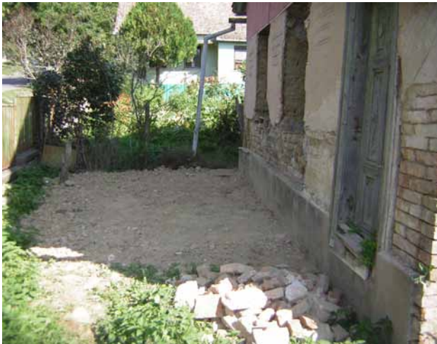
Neue Horizontalsperre unter vorhandenem Giebel einmauern
