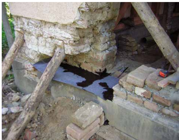
Neue Horizontalsperre unter vorhandenem Giebel einmauern
